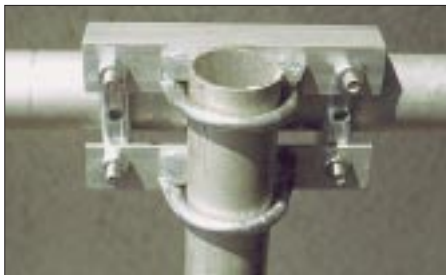
Bild 17: Mechanische Realisierung der Verbindungsstellen bei Rohren für ein H-Kreuz mit Aluminiumwinkeln Fotos: DK7ZB
